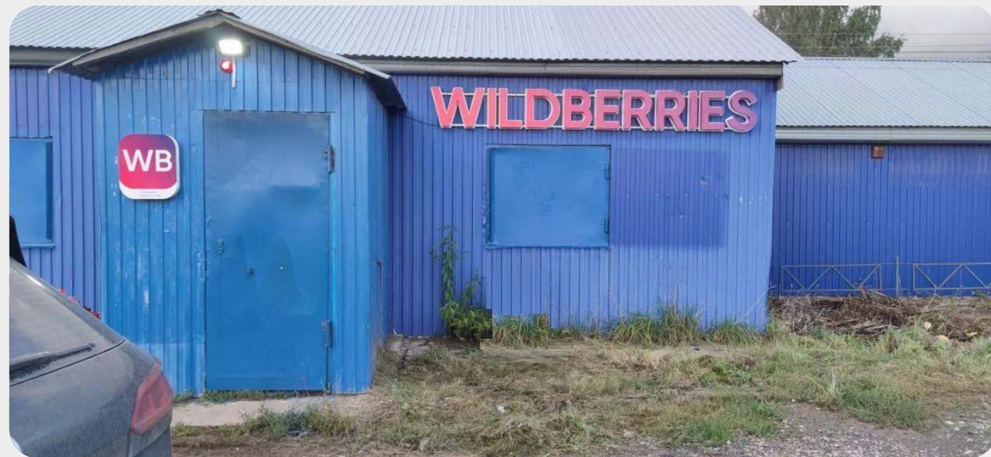
В здании с фасадом в плохом состоянии
